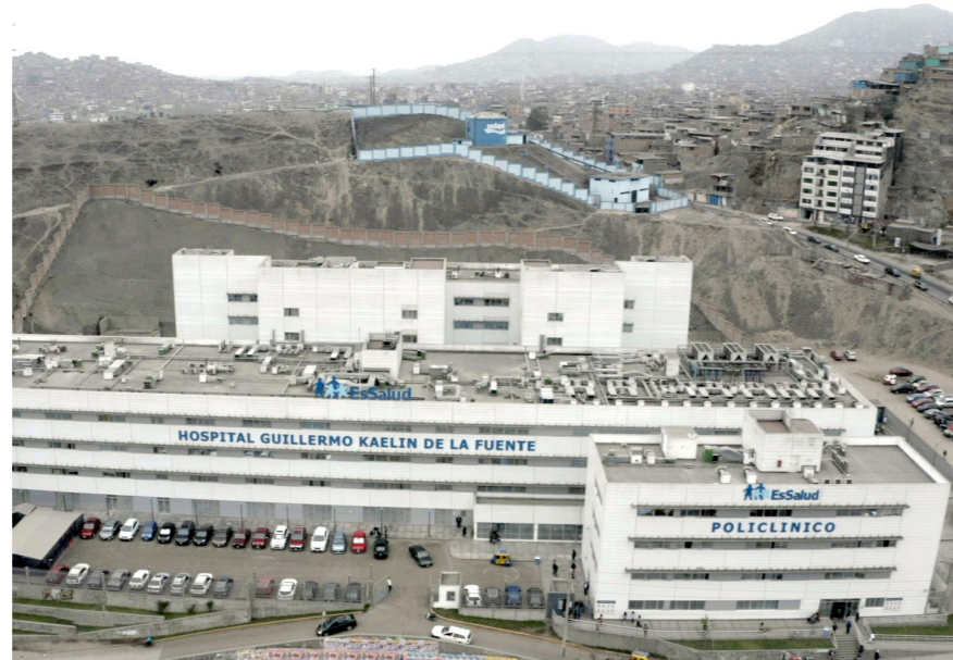
Exterior del Complejo Hospitalario Guillermo Kaelin
